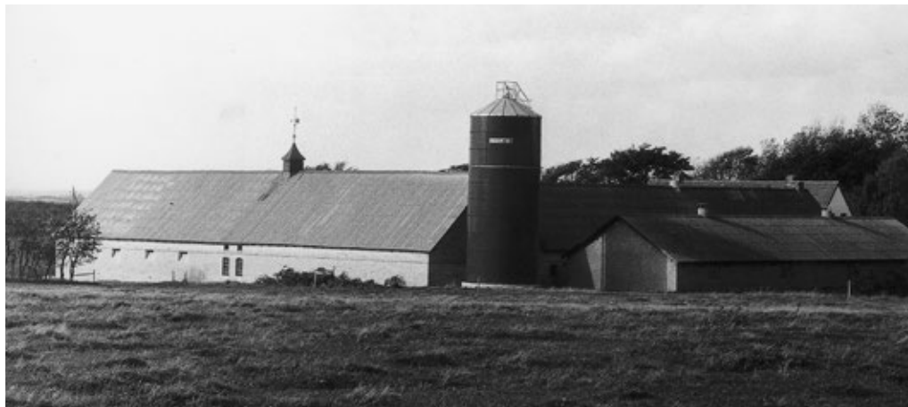
Silo til 1127 tdr. korn, opstillet i 1974 hos gdr. Kr. Eriksen, »Ejstrupgaard«, Løgstør.
