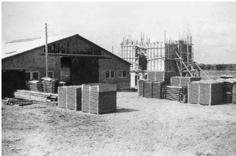
Der bygges savsmuldssilo og varmeanlæg 1949–50.
