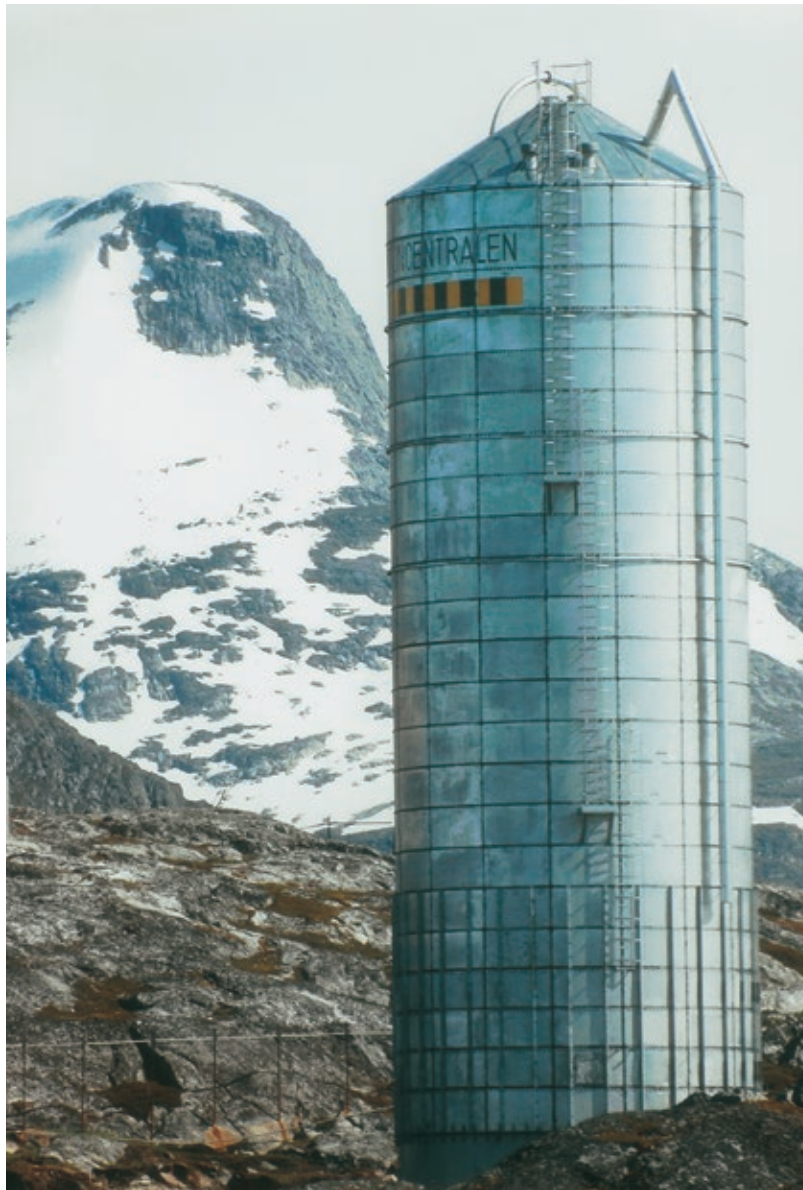
Betoncentralens 32 meter høje silo kan rumme 1523 m 3 cement. Opført i Nuuk, 1996.
