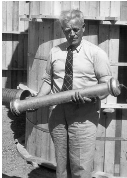
Bjerre Jensen med spjældet, der lukker for luften i det perforerede ventiltrør.
