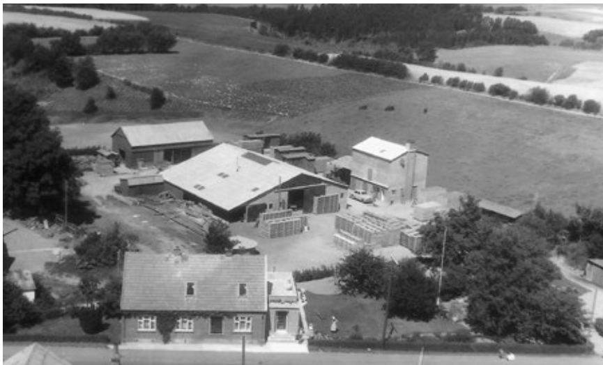
Assentoft Silofabrik 1952. Der var kontor i huset i forgrunden.
