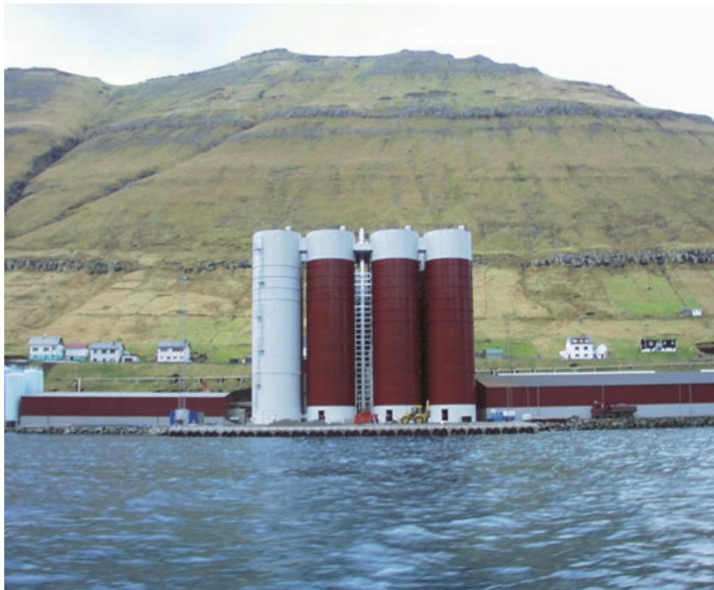
I 2004 opførtes 8 stk. 35,50 m høje siloer med en diameter på 8,86 m til fiskefoder for firmaet P/F Havsbrün, Fugleffjord, Østerø, Færøerne. Der måtte først opføres et kajanlæg til siloerne at stå på.
