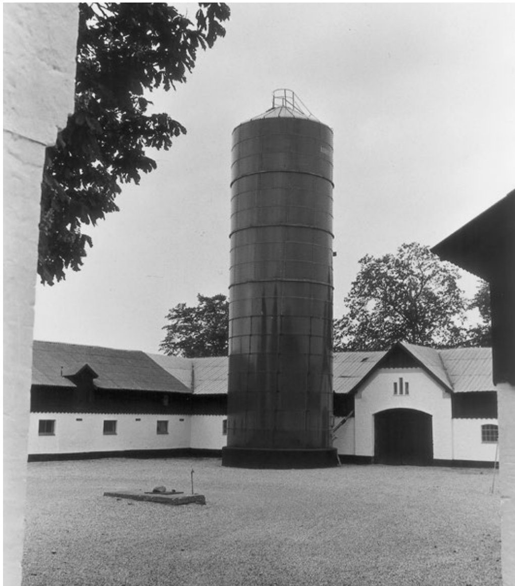
Silo til 2814 tdr. korn opstillet i 1969 hos gdr. Tage Særkjær, Ødum, Hadsten. Senere blev siloen forhøjet til at kunne rumme 4074 tdr. korn.
