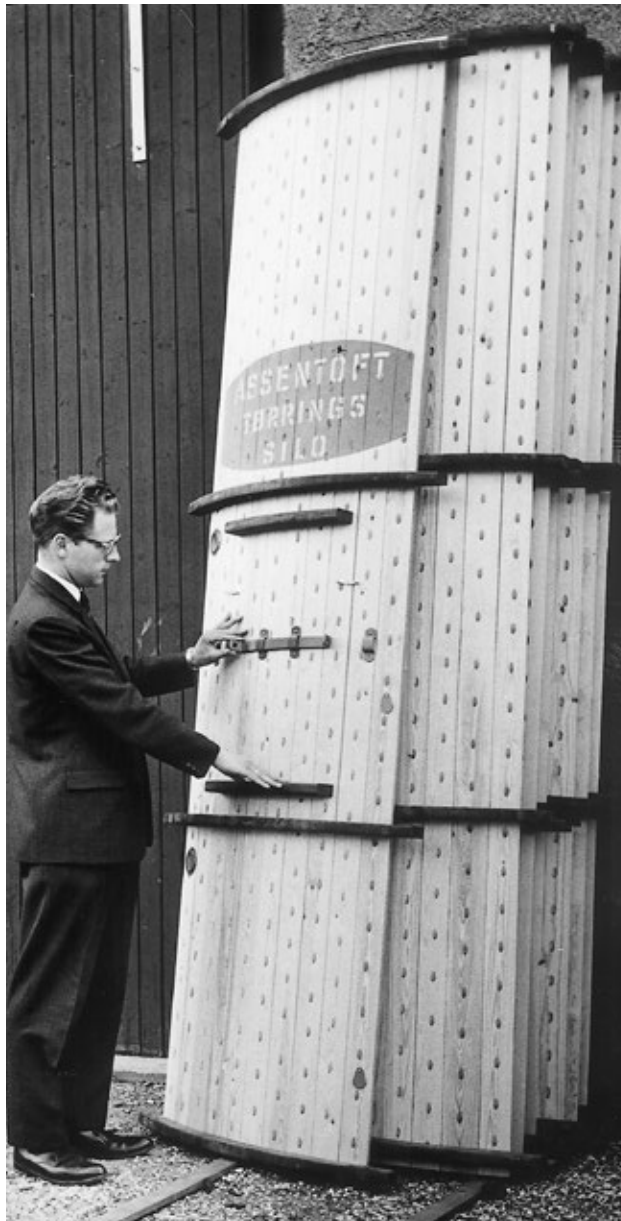
Carl Damgaard Nielsen ved en tørringssilo med skråtstillede huller. 1962.
