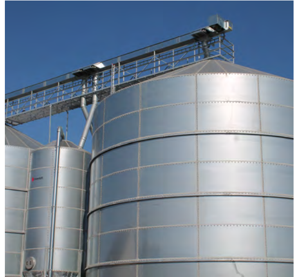
To stk. 1160/9 (total 2494 m 3 ). To stk. soyasiløer (total 134 m 3 ). Helsvejt gangbro med 120 t redler.
