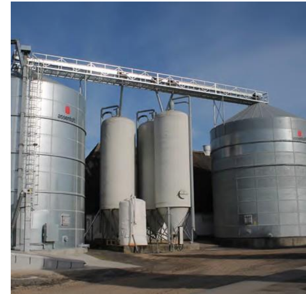
930/9 á 786 m3, 40 ton transport med grop och helsvetsad gångbro på 24 m.
