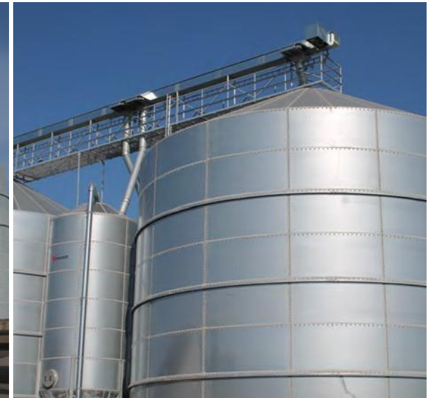
Två st. 1 160/9 (totalt 2 494 m3). Två st. sojasilor (totalt 134 m3). Helsvetsad gångbro med 120 ton transportör.
